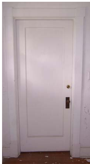
Image 3.35: Doors D102 and D106
