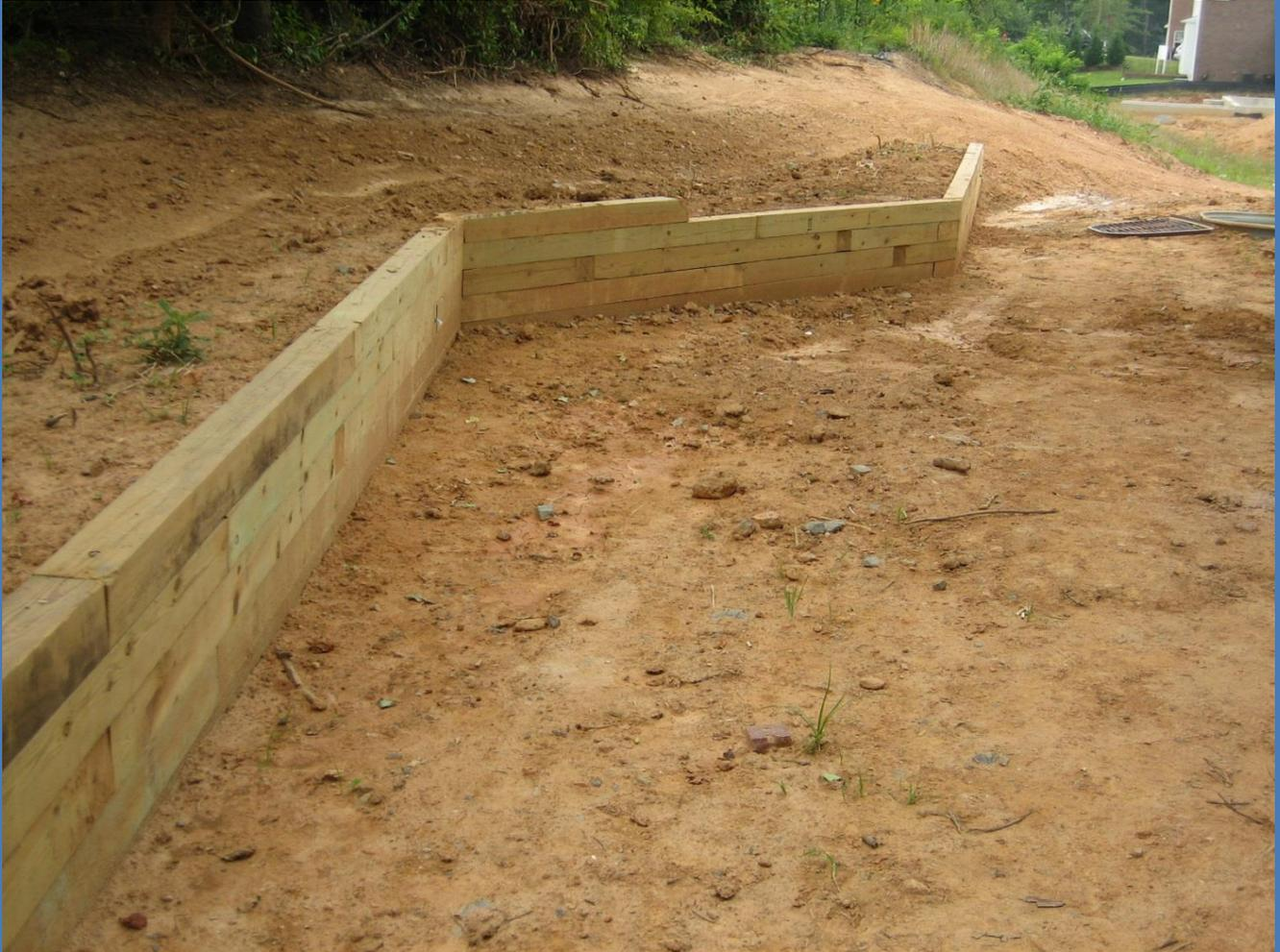
본 설계 문서는 주거용, 비계층화, 비적층화되지 않은 옹벽에 적용되며, 이 벽은 평평한 백필(되메우기)이 있으며 추가 하중이 없이 4피트 이하의 흙을 유지합니다. 옹벽은 여기의 세부 사항에 따라 시공되어야 합니다. 이러한 세부 정보의 사본은 작업 현장에 있어야 하며 필요한 각 검사 중에 검사관이 사용할 수 있어야 합니다.
