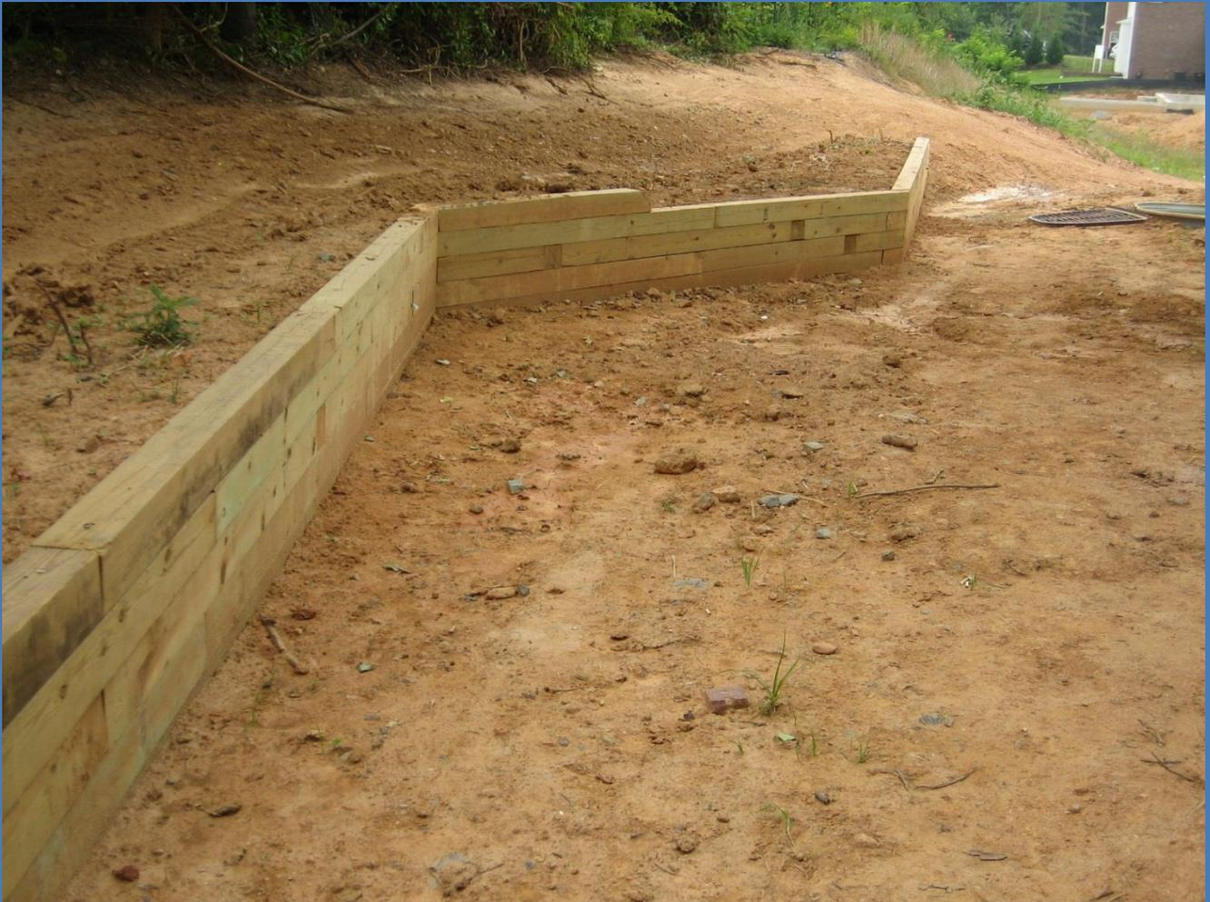
Este documento de diseño se aplica a muros de contención residenciales, no escalonados, no apilados, con relleno nivelado y sin carga adicional que retienen no más de 4 pies de tierra. Los muros de contención deben construirse de acuerdo con los detalles aquí descritos. Se requiere que una copia de este documento esté en el sitio de trabajo y esté disponible para el inspector durante cada inspección requerida.
