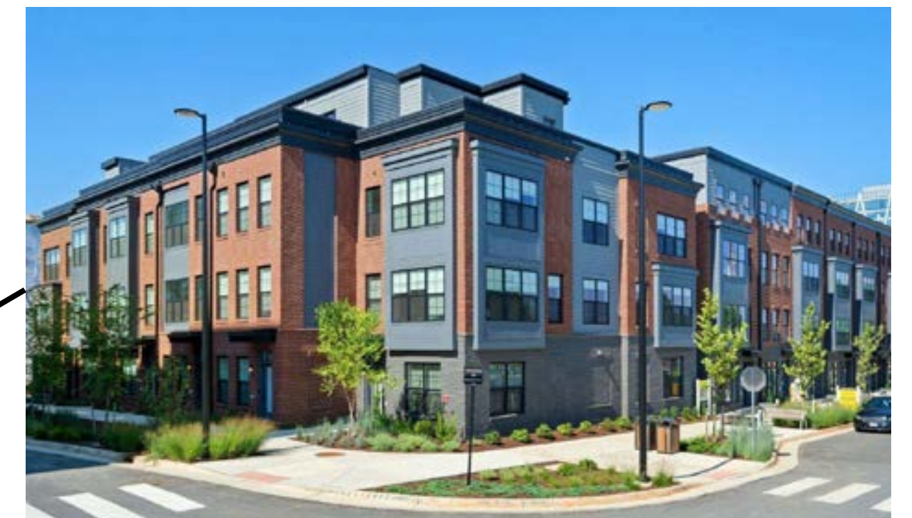
Ejemplo de desarrollo residencial multifamiliar de poca altura en una calle transitible
