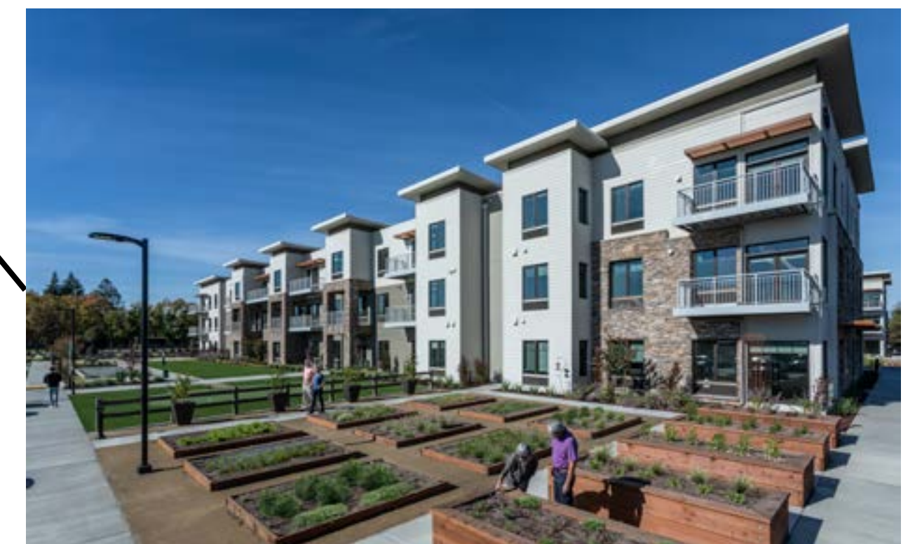
Ejemplo de residencial multifamiliar de poca altura con espacios de servicios al aire libre
